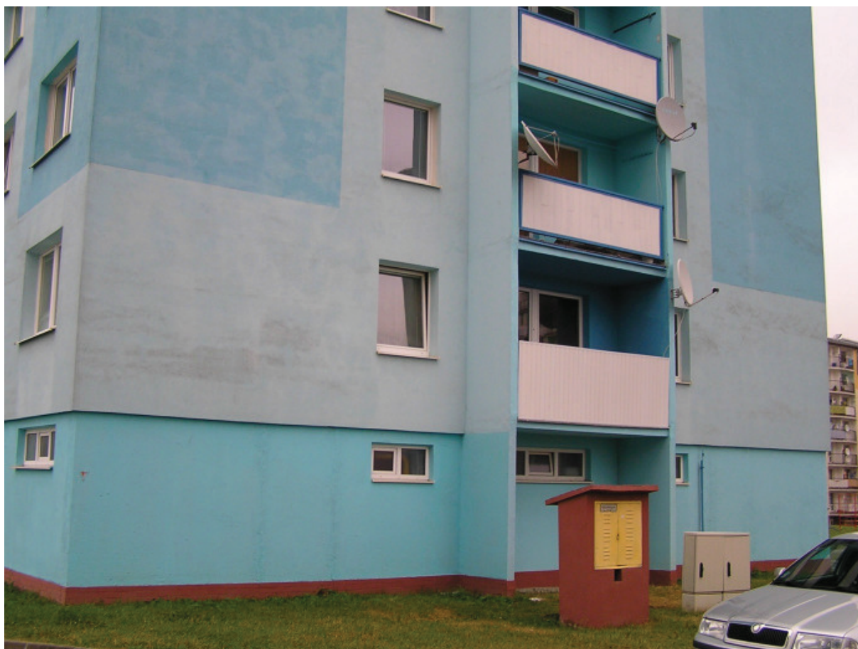
Obr. 8 – Bytový dom Zobor , pohľad na dom po búrke zo dňa 20.08.2013
