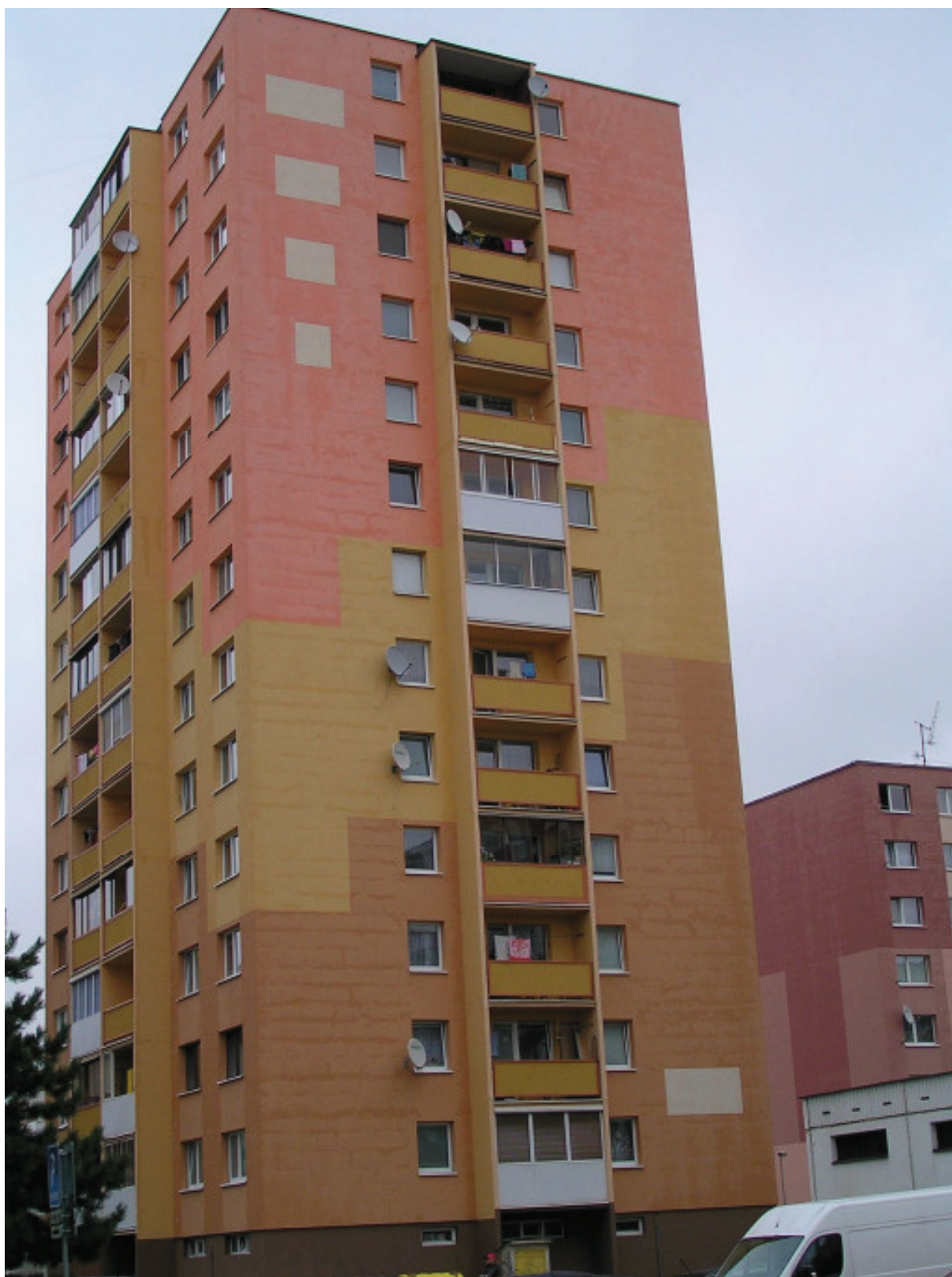
Obr. 5 – Bytový dom Desna , pohľad na dom po búrke zo dňa 20.08.2013
