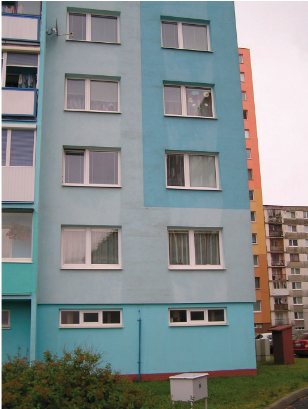
Obr. 9 – Bytový dom Zobor , pohľad na dom po búrke zo dňa 20.08.2013
