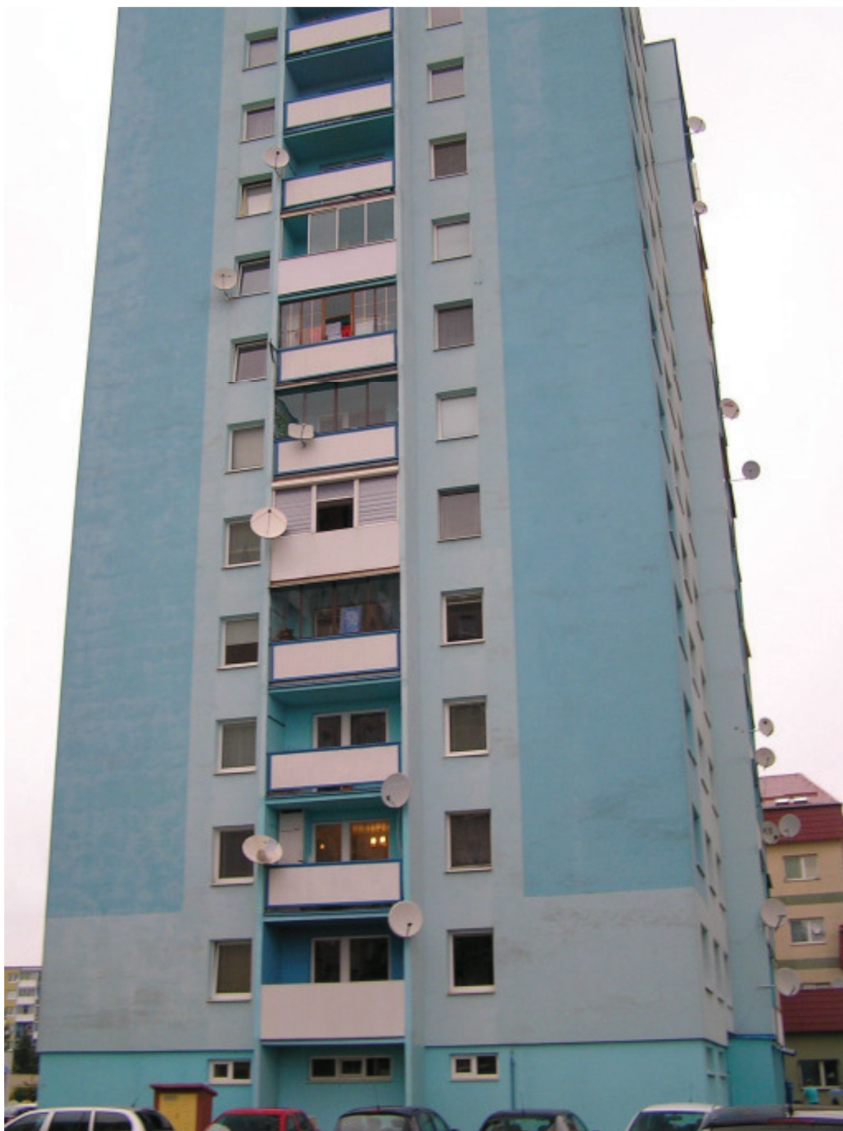
Obr. 7 – Bytový dom Zobor , pohľad na dom po búrke zo dňa 20.08.2013
