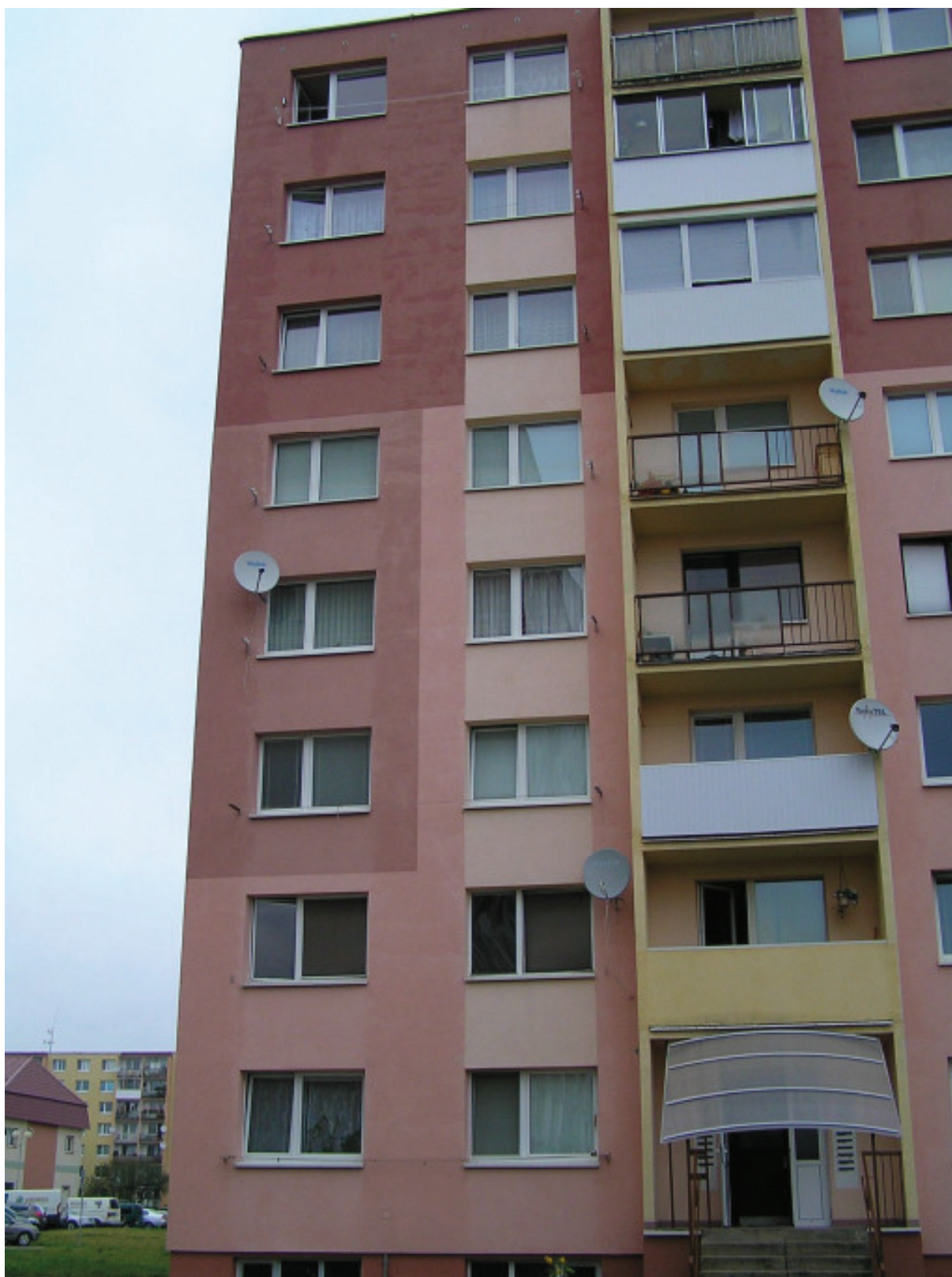
Obr. 10 – Bytový dom Jenisej , pohľad na dom po búrke zo dňa 20.08.2013
