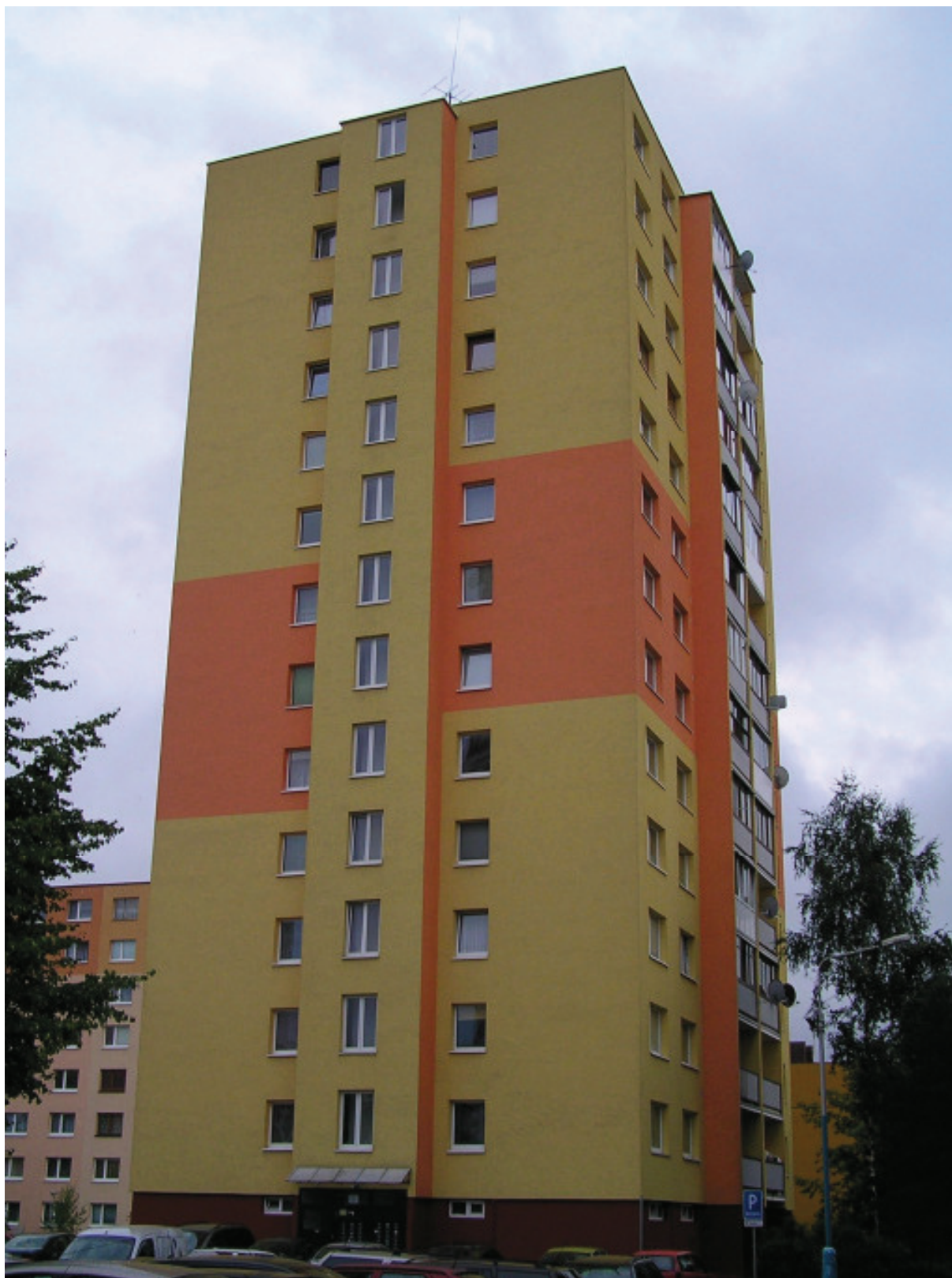
Obr. 13 – Bytový dom Jana , pohľad na dom po búrke zo dňa 20.08.2013
