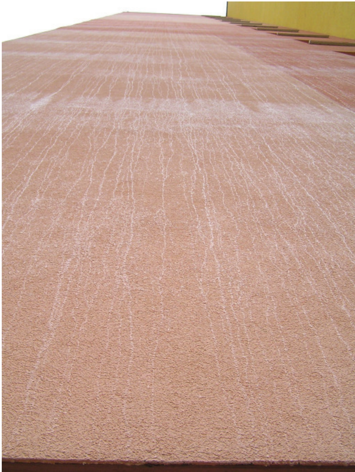
Obr. 4 – Bytový dom Lena , pohľad na dom po búrke zo dňa 20.08.2013 , detail na stekanie dažďovej vody po povrchu silikonovej omietky , striebřisté sfarbenie na stene domu je svetelný efekt odrazu svetla na kvapkách vody
