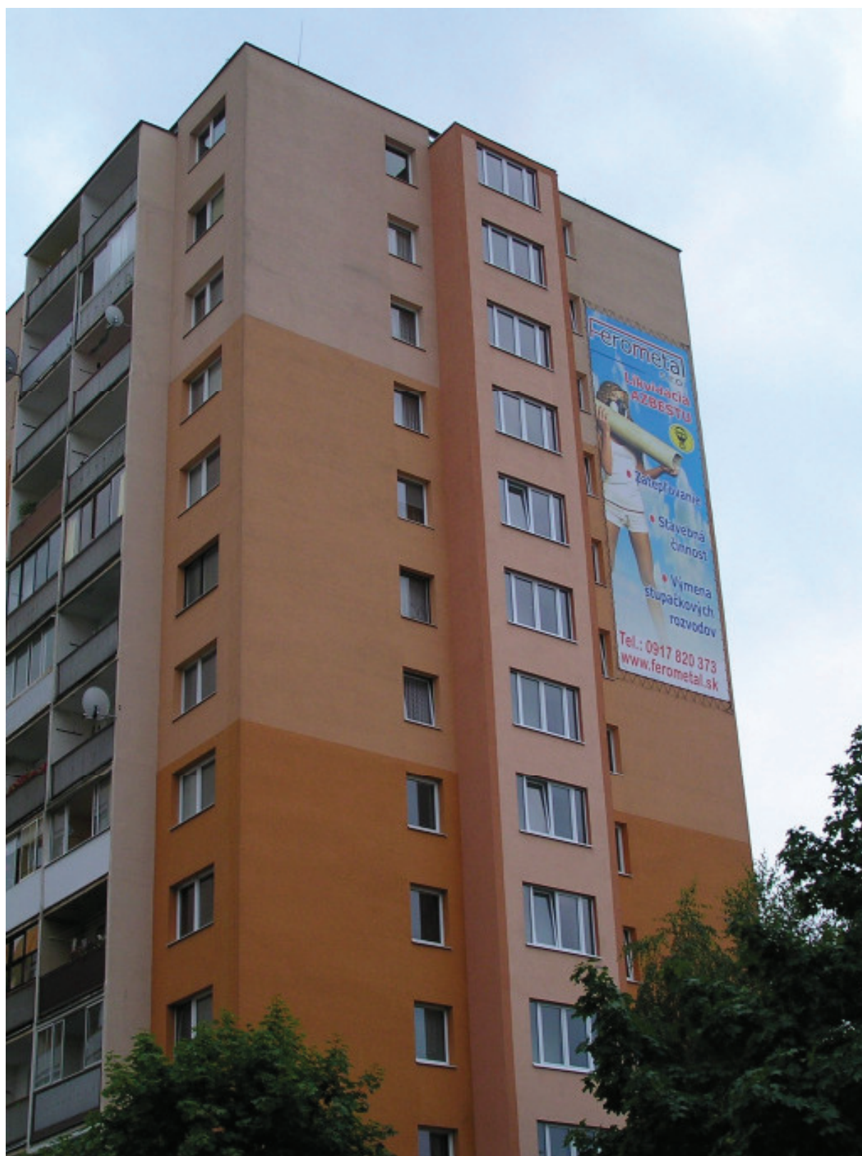
Obr. 12 – Bytový dom Maja , pohľad na dom po búrke zo dňa 20.08.2013
