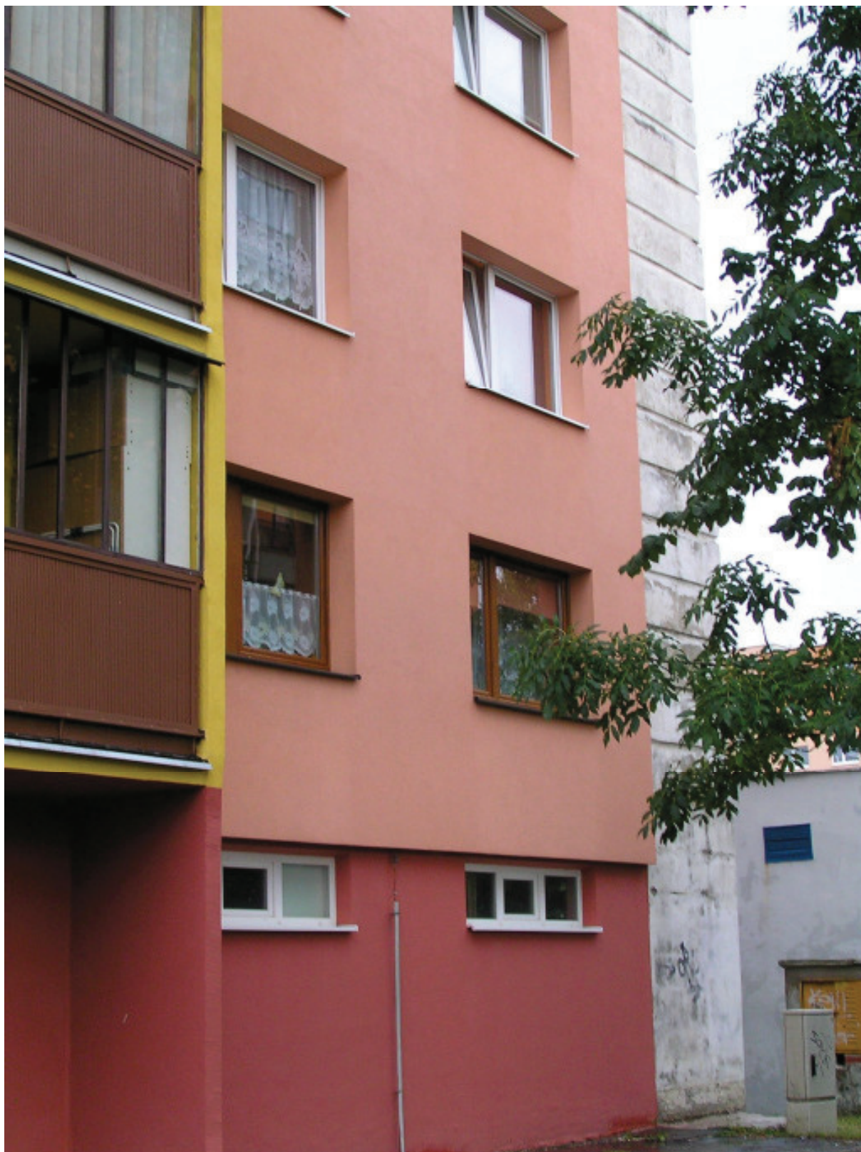
Obr. 2 – Bytový dom Lena , pohľad na dom po búrke zo dňa 20.08.2013 , striebisté sfarbenie na stene domu je svetelný efekt odrazu svetla na kvapkách vody
