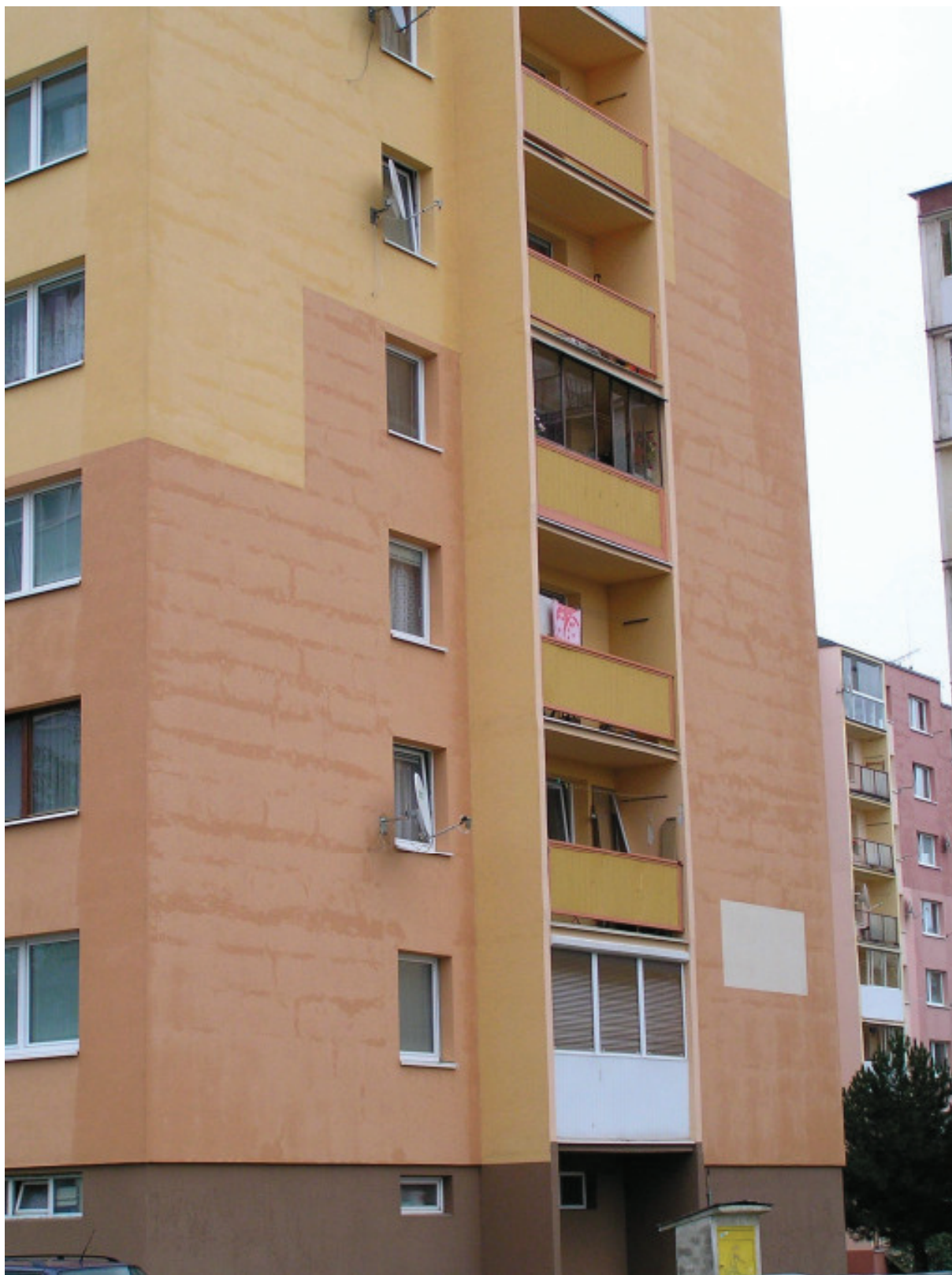
Obr. 6 – Bytový dom Desna , pohľad na dom po búrke zo dňa 20.08.2013
