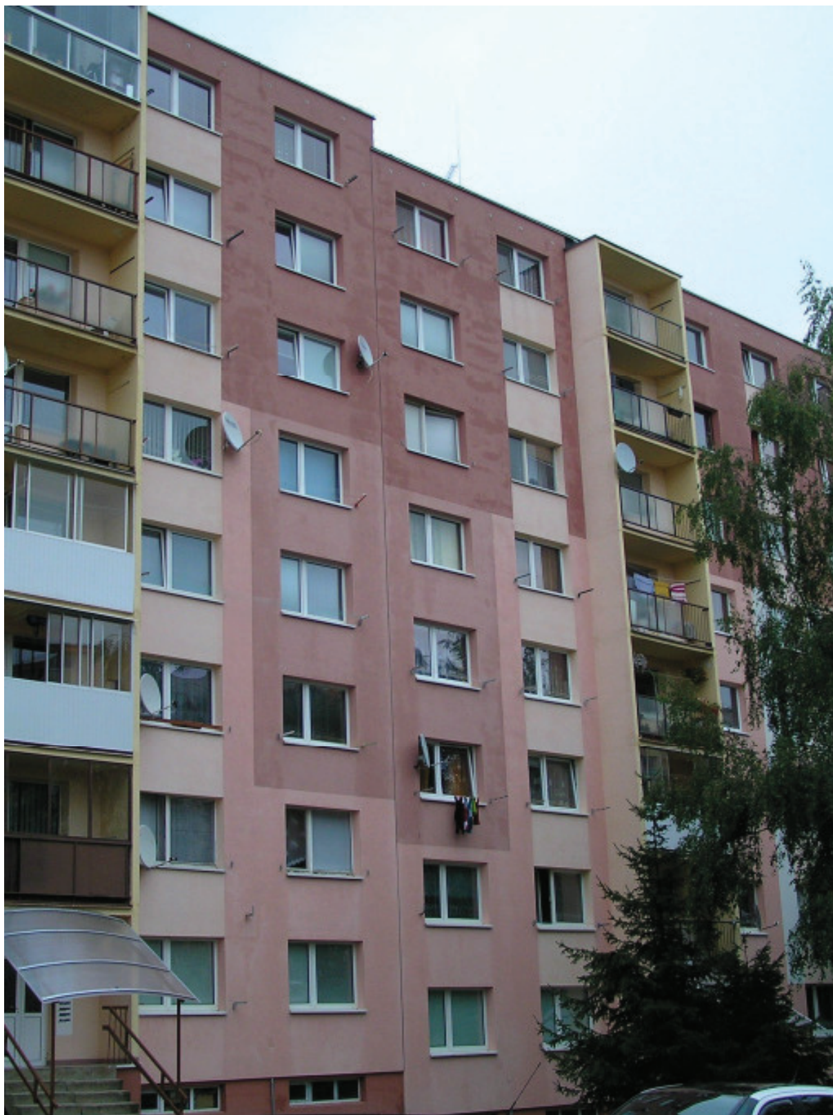
Obr. 11 – Bytový dom Jenisej , pohľad na dom po búrke zo dňa 20.08.2013
