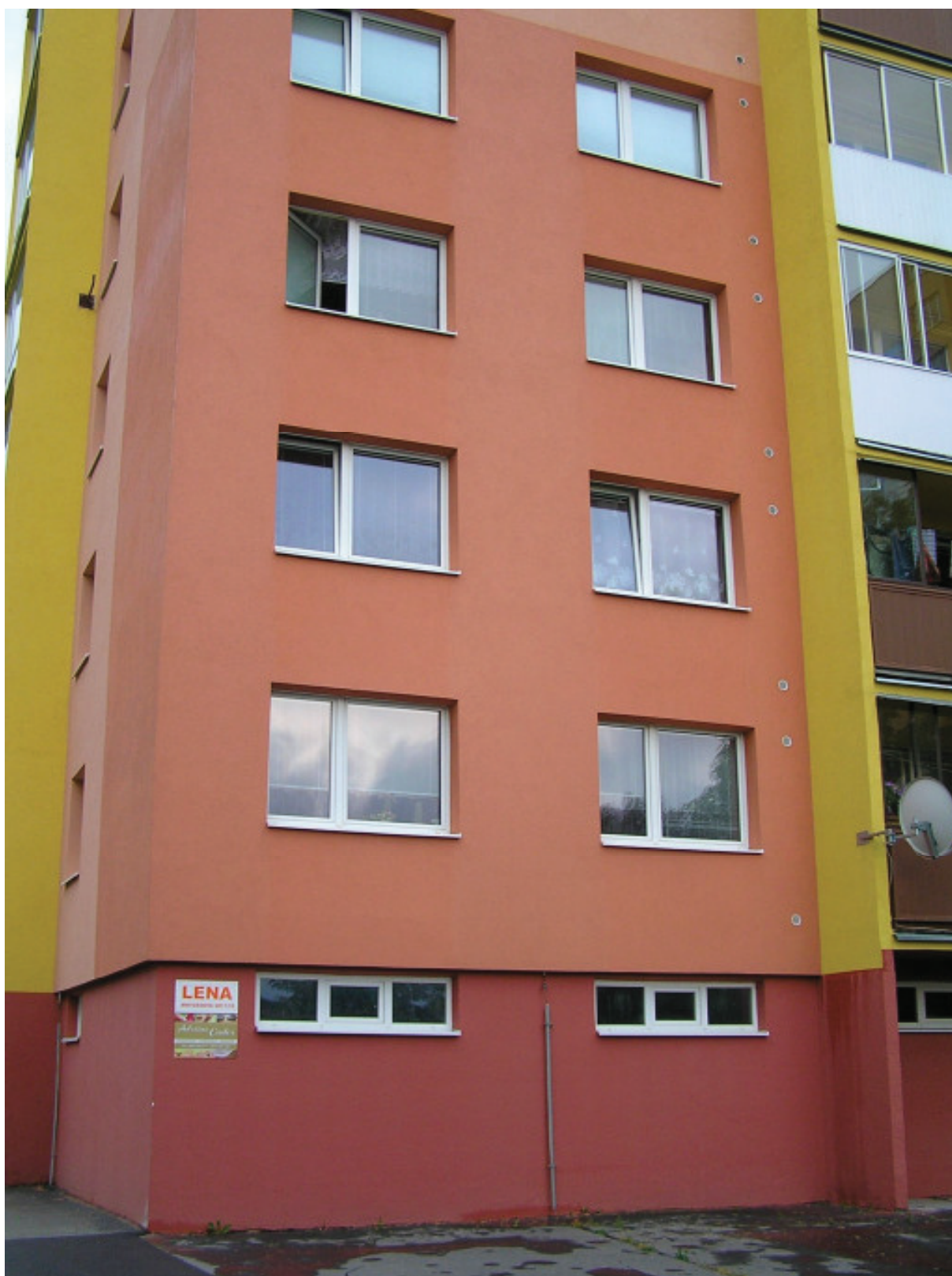
Obr. 1 – Bytový dom Lena , pohľad na dom po búrke zo dňa 20.08.2013 , striebisté sfarbenie na stene domu je svetelný efekt odrazu svetla na kvapkách vody
