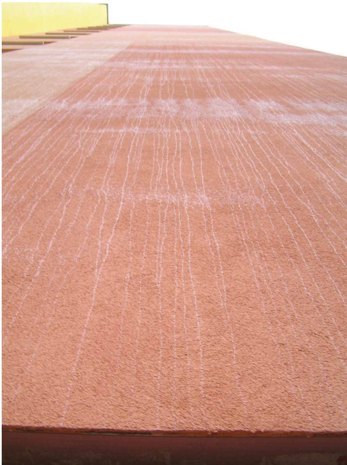
Obr. 3 – Bytový dom Lena , pohľad na dom po búrke zo dňa 20.08.2013 , detail na stekanie dažďovej vody po povrchu silikonovej omietky , striebřisté sfarbenie na stene domu je svetelný efekt odrazu svetla na kvapkách vody
