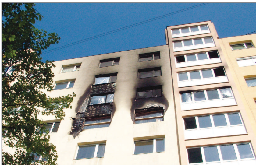
Budova na ulici Középszer po požiaru.
