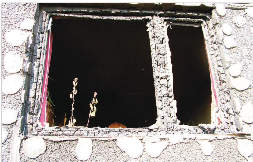
Oheň zničil fasádny zatepľovací systém.
