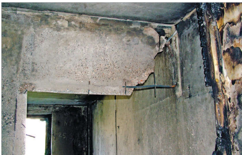
Vnútroň priestory jedného z bytov postihnutých požiarom.
